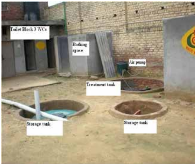
चित्र 2.27 एलडीडीपीई निर्मित स्थिरीकरण संपर्क वातन प्रणाली
