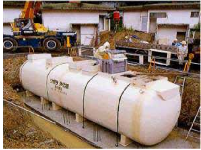
चित्र 2.26 एक प्ररूपी पैकेज संपर्क वातन प्रणाली (स्रोत निशिहारा ऐन्वा, प्रोद्योगिकी जापन)
